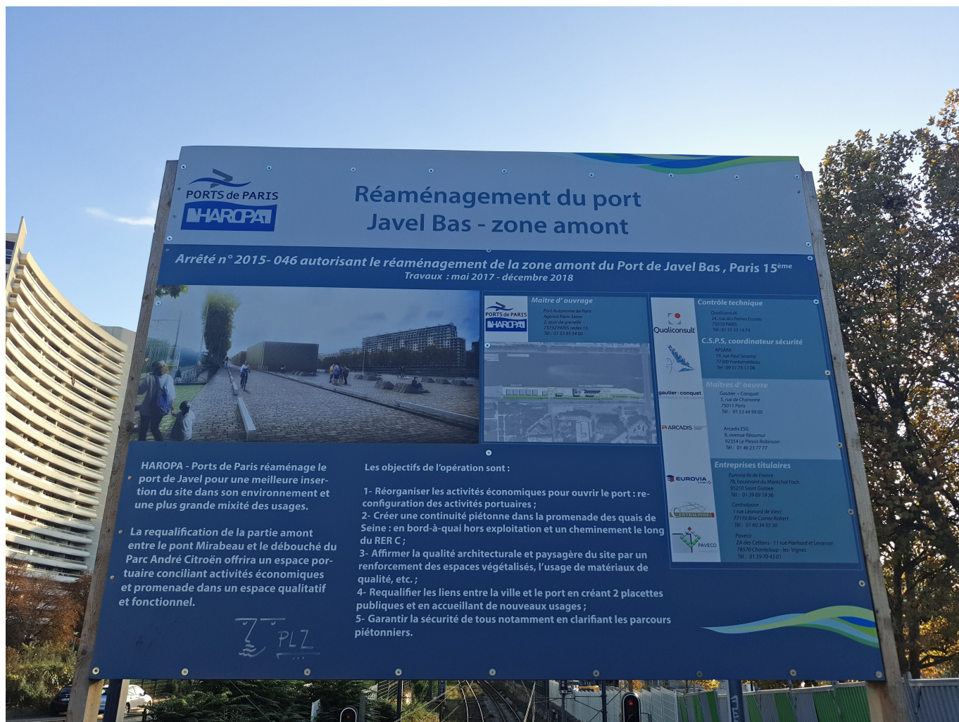
Une site industriel à ciel ouvert en plein Paris, sous le pont Mirabeau, non loin de la Tour Eiffel
